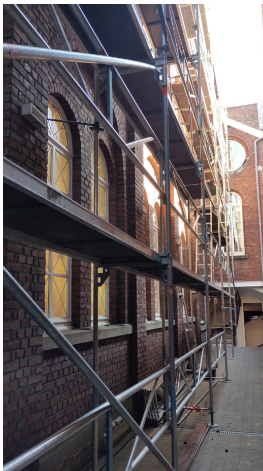
Les travaux de rénovation du toit du temple vont débuter dans les prochains jours
